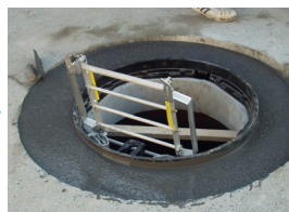
⑥路盤材充填作業 鉄筋を設置し、ラウンドベースを用いて路盤部を充填します。
