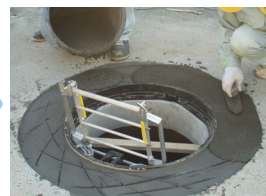
⑦表層材の充填・敷き均し 表層材を敷き均し、周辺路面とレベルを合わせます。
