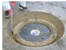
③鉄蓋及び土砂除去作業 切断完了後、鉄蓋及びマンホール周辺の土砂を除去します。
