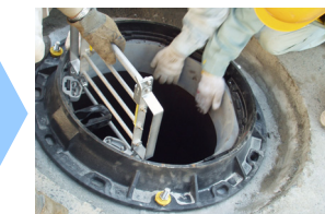
⑤内型枠装着 調整部内面に内型枠を曲げながら挿入し、内周に密着させます。
