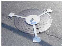
①作業準備 センタリング治具を固定します。
