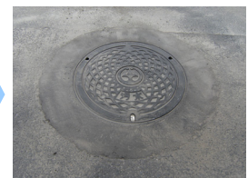
⑧完成 硬化後、周辺を清掃して完了です。
