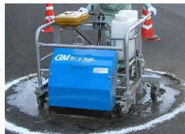
②切断作業 GMラウンドカッターを設置し、5cm毎に最大深さ15cmまで切断します。
