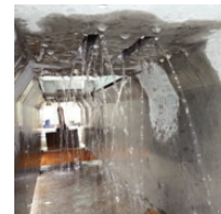
側溝内への排水状況
